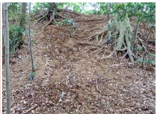
土塁の土の流出
