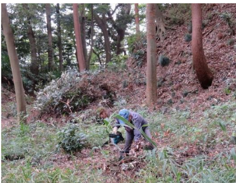
樹木伐採後の整備
