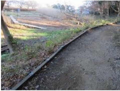
園路の縁は木道補修の残材を利用して綺麗に整備できている
