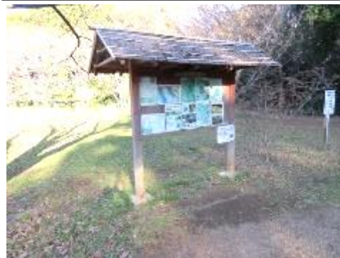
芝生広場の掲示板は脚のひび割れと柱の腐れのため、補修をどのようにするかを検討
