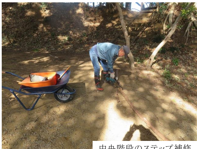
中央階段のステップ補修
