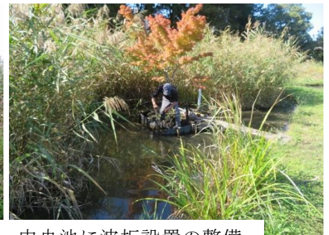
中央池に波板設置の整備 霜田橋の親水エリアの整備
