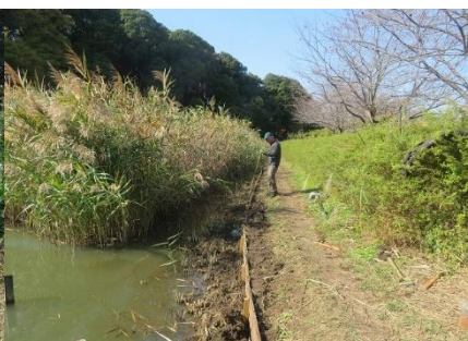
ミクリ池縁の土留め板の施設h50m以上を完成しました
