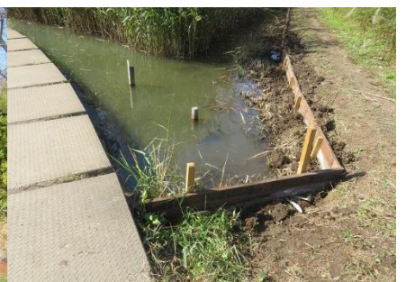
ミクリ池縁の土留め板の施設h50m以上を完成しました
