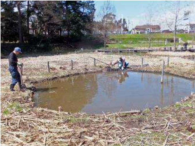
トンボ池の淵の土留めに畔板を施設
